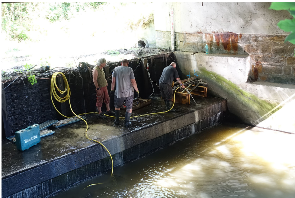
Obrázek 5. Provádění vrtu 4 do konstrukce severní opěry.
